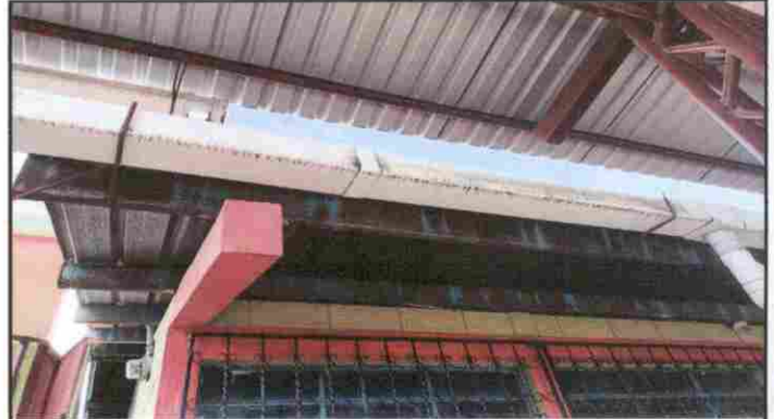
Foto 2. Estructura de techo
