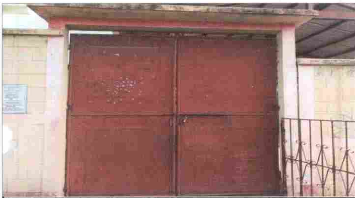
Foto 3. Sustitución de Porton Principal
