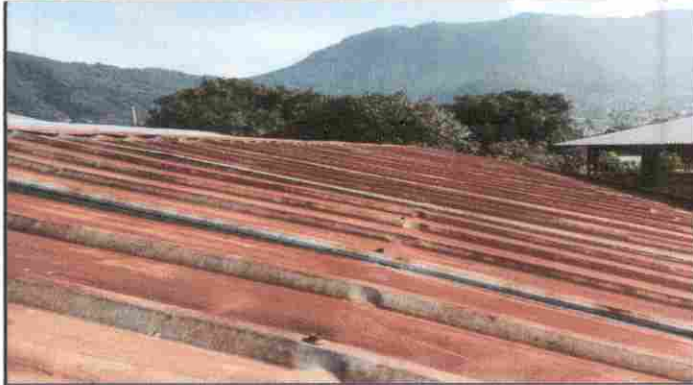
Foto 1. Sustitución de Lamina por Lamina troquelada
