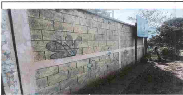
Foto 5. Pintura en muros exteriores e interiores
